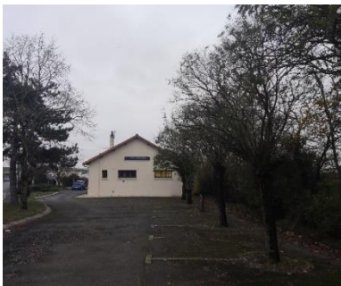
RADIO VAL D'OR : Nettoyage de la façade et toiture entretien du
