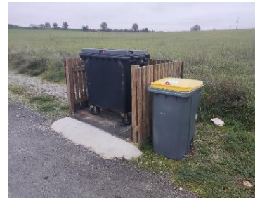
MAISON DE SANTE ST LOUP LAMAIRE : Aménagement d'une plateforme OM
